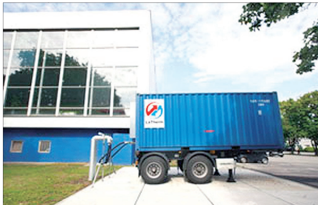
Der Wärmecontainer im Einsatz bei einem Hallenbad.
